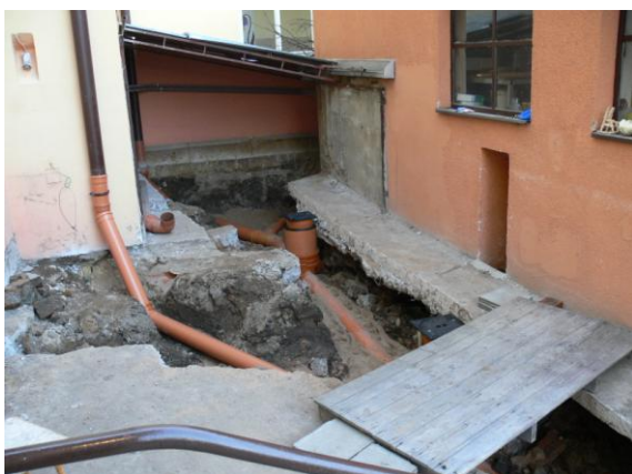
Oprava kanalizace na školním dvoře
